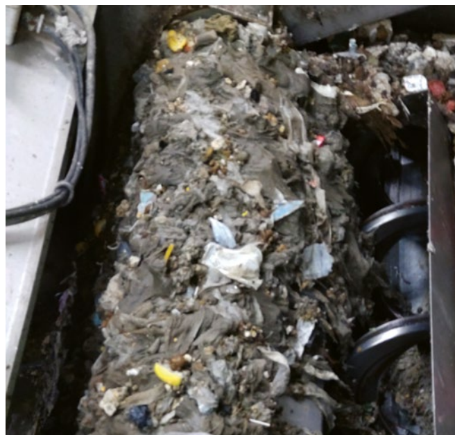
Här avlägsnas skräp som felaktigt spolas ner i avloppet, såsom våtservetter, plast och annat avfall. Foto: Miriam Norman
