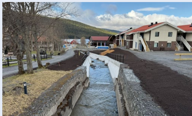
Åre kommuns översvämnings- och erosionskydd vid Mörviksån. Foto: Myndigheten för civilt försvar
