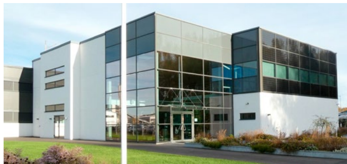
Fabriksbyggnaden på Rya industriväg i Frillesås
