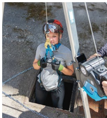
Pääsy ahtaisiin tiloihin
